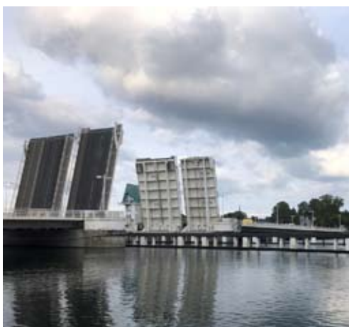
Klappbrücke in Kappeln an der Schlei
